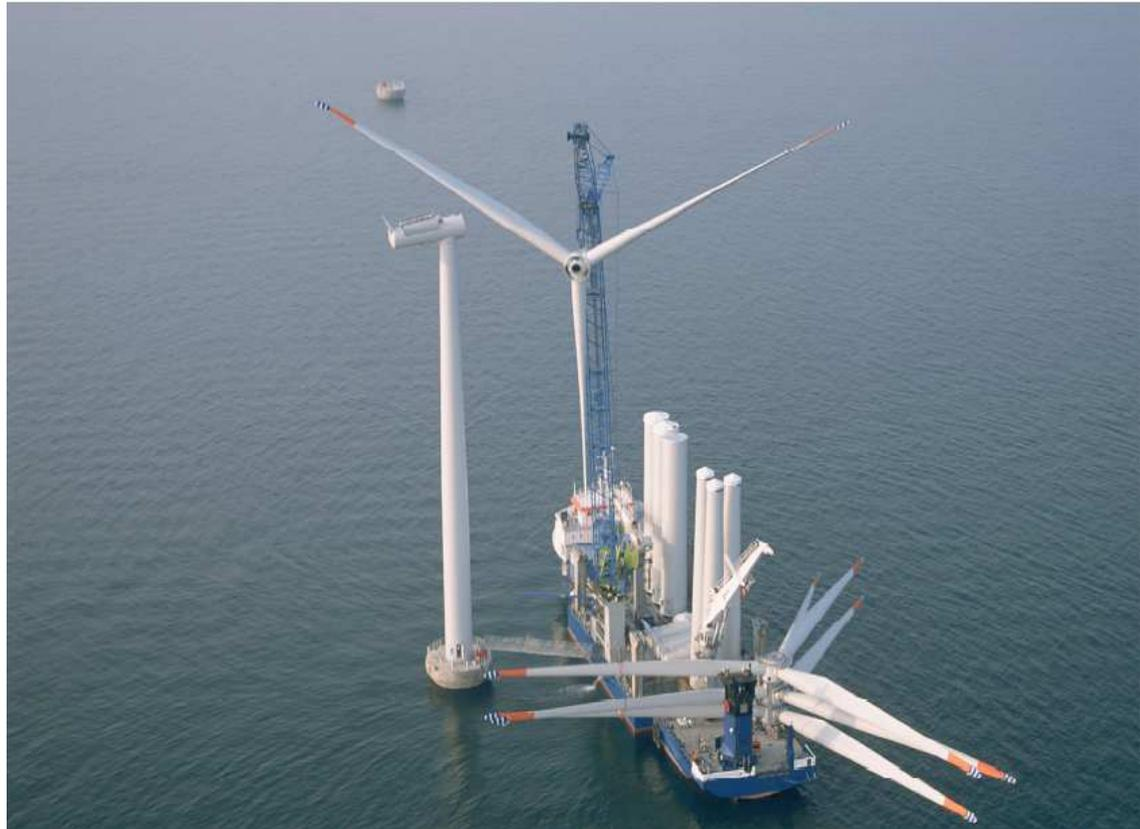
*Montage des éoliennes de 2,3MW de Nysted (Danemark) par un navire spécialisé*
